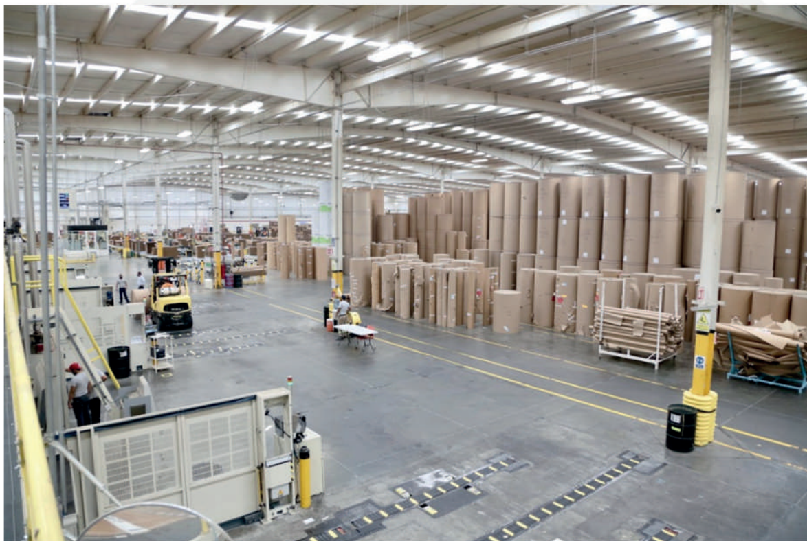
Planta Corrugados Monterrey
